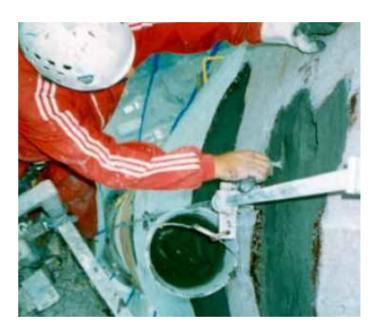
La temperatura del soporte debe ser como mínimo de +5°C y como máximo de +30°C y se procurará que las temperaturas sean uniformes durante la aplicación y el endurecimiento.
